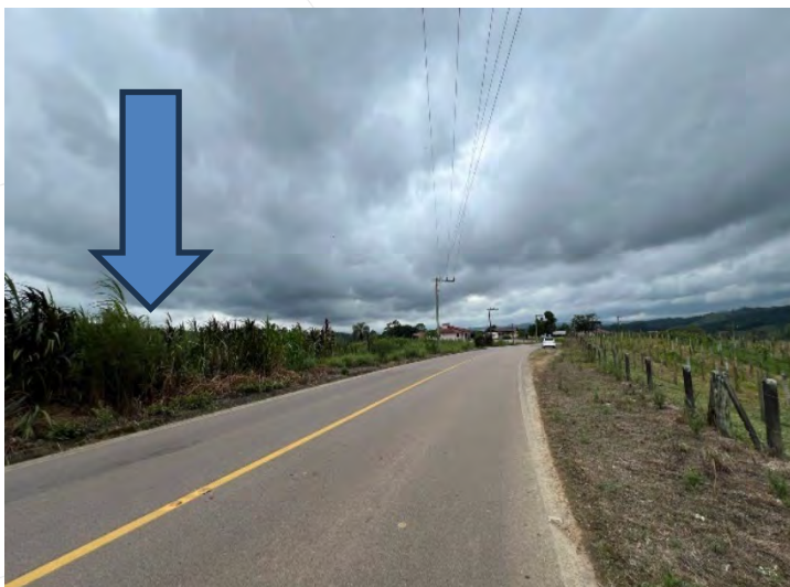
Figura 08 – Rodovia pavimentada em asfalto
