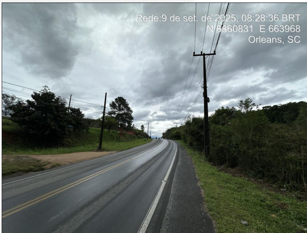
Figura 7. O entorno do empreendimento já possui rede elétrica fornecida pela CELESC.
