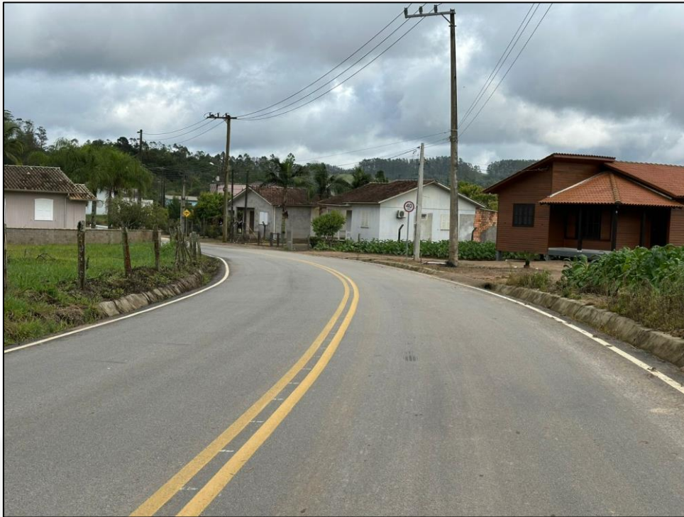
Figura 9. Foto da rede de drenagem e rede elétrica na Estrada Geral Oratório.
