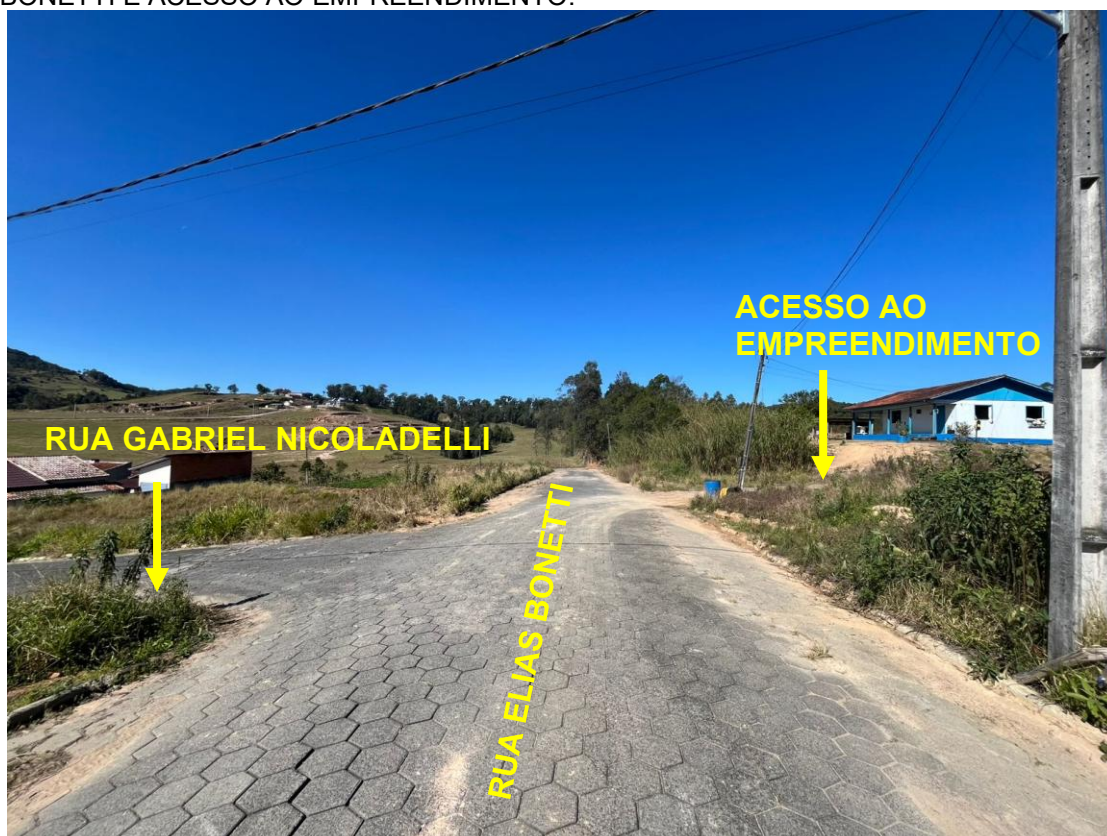
FIGURA 26: VISTA DA INTERLIGAÇÃO RUA GABRIEL NICOLADELLI COM A RUA ELIAS BONETTI E ACESSO AO EMPREENDIMENTO.
