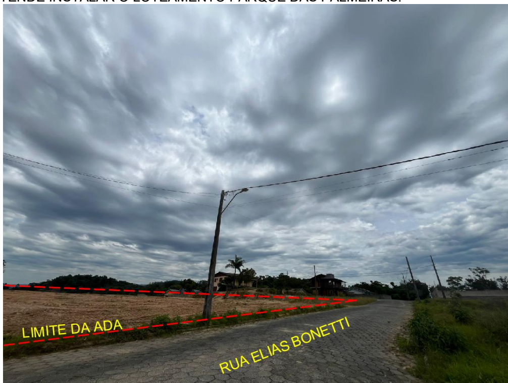
FIGURA 09: VISTA DA REDE DE ENERGIA ELÉTRICA EM FRENTE AO IMÓVEL ONDE SE PRETENDE INSTALAR O LOTEAMENTO PARQUE DAS PALMEIRAS.
