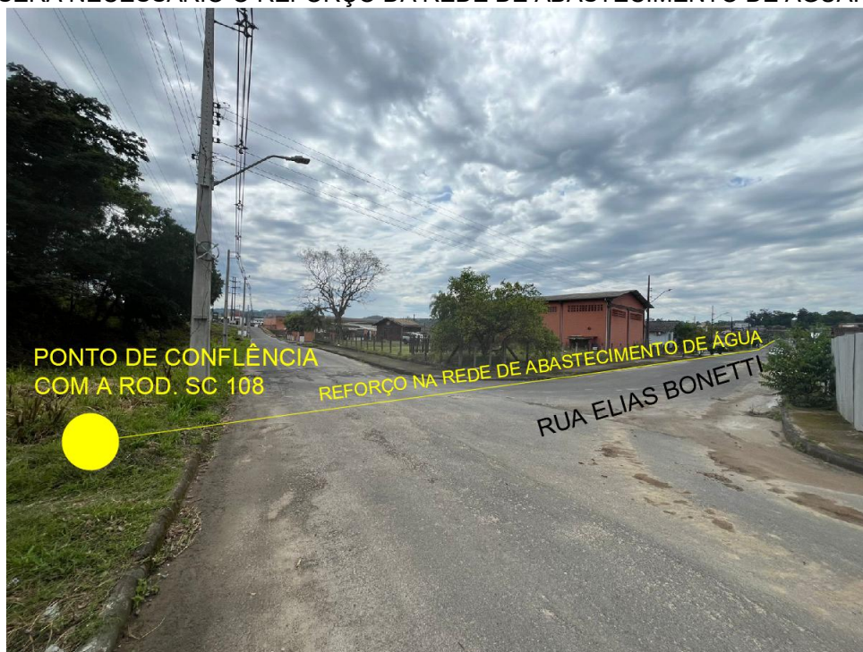
FIGURA 10: VISTA DA RUA ELIAS BONETTI COM A MARGEM DA RODOVIA SC 108, LOCAL ONDE SERÁ NECESSÁRIO O REFORÇO DA REDE DE ABASTECIMENTO DE ÁGUA.
